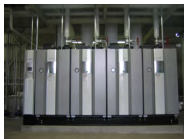
神戸工場コージェネレーションシステム 液化天然ガスに燃料転換したボイラー
