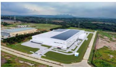
『Pocky』の最新鋭技術が詰まった新工場、Glico Manufacturing Indonesia が2022年3月末に完成しました。敷地面積は約6万㎡、建物の延床面積は約5万7,000㎡で、『Pocky』の自社工場として過去最大規模です。太陽光パネルを屋根に設置し、2023年度の発電量は168万kWh、年間で約1,464tのCO<sub>2</sub>排出削減に貢献しました。
